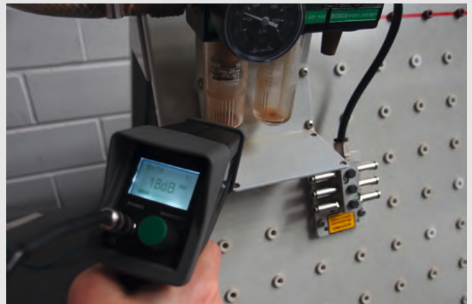
Ultraschallmessung an einer Druckluftleitung © Handwerkskammer Koblenz
